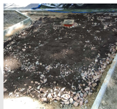
Nawierzchnie na podbudowie z antykompresyjnej mieszanki kamienno-glebowej SGGW ułożone na korzeniach drzew w Alei Marii Dąbrowskiej w Komorowie Fot. M. Suchocka
