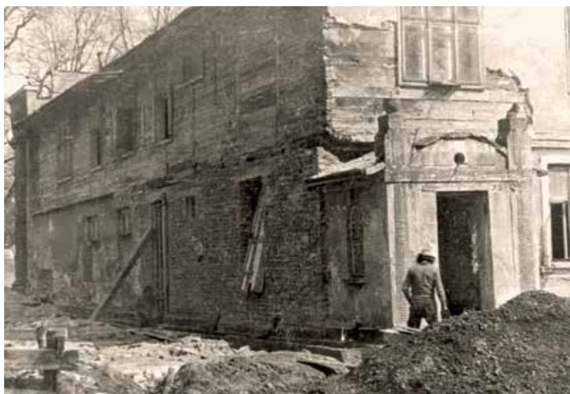
Ryc. 7. Pałac w Bolestraszczykach w trakcie prac remontowych w 1976 r. (fot. ze zbiorów Archiwum Arboretum w Bolestraszczykach).
