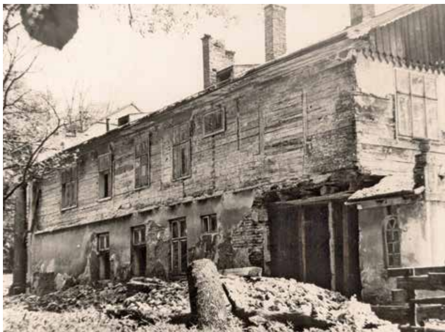
Ryc. 6. Pałac w Bolestraszczykach w trakcie remontu w 1976 r., elewacja zachodnia. (fot. ze zbiorów Archiwum Arboretum w Bolestraszczykach).
