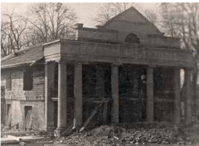
Ryc. 5. Pałac w Bolestraszcach w trakcie remontu w 1976 r. (fot. ze zbiorów Archiwum Arboretum w Bolestraszcach).
