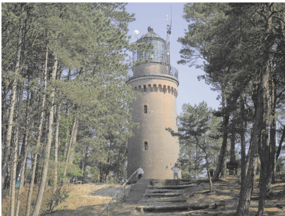
Latarnia morska w Czołpinie
