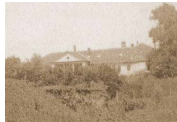
DETAIL: Taras Fredrówki z widocznymi czterema kolumnami. Po II wojnie zabudowano je ścianą.
