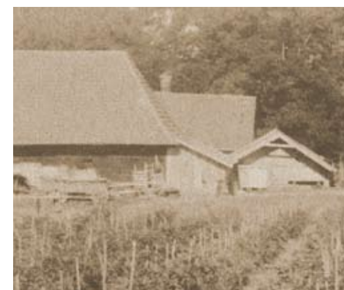
DETAIL: Budynki gospodarcze.
