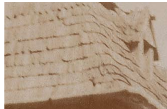
DETAL: Łamany dach wieżyczki kryty gontem.
