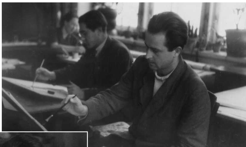
W Zakładzie Architektury Krajobrazu
