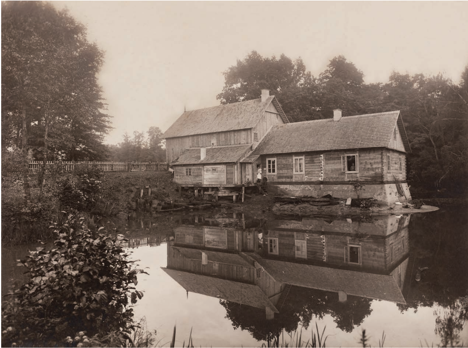
Młyn w Podzamczu, przy drodze do Polika; od niedawna w zupełnej ruinie.
