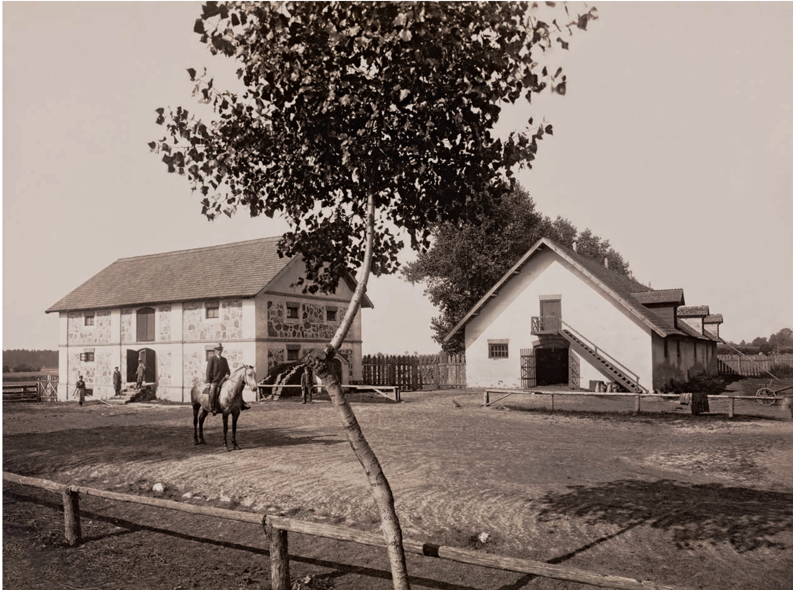
Folwark w Krępie; pod ścianą stopy rurek drenarskich – Rożyński prowadził melioracje na wielką skalę.
